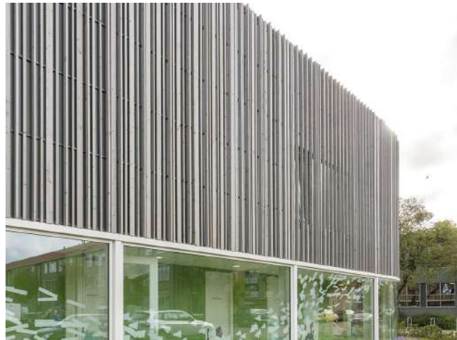
Sporthal Voorburg, Slangen+Koenis Architecten
