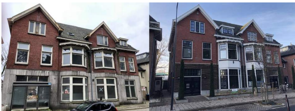
Renovatie monumentale villa Ripperdastraat 9-11 te Enschede.
