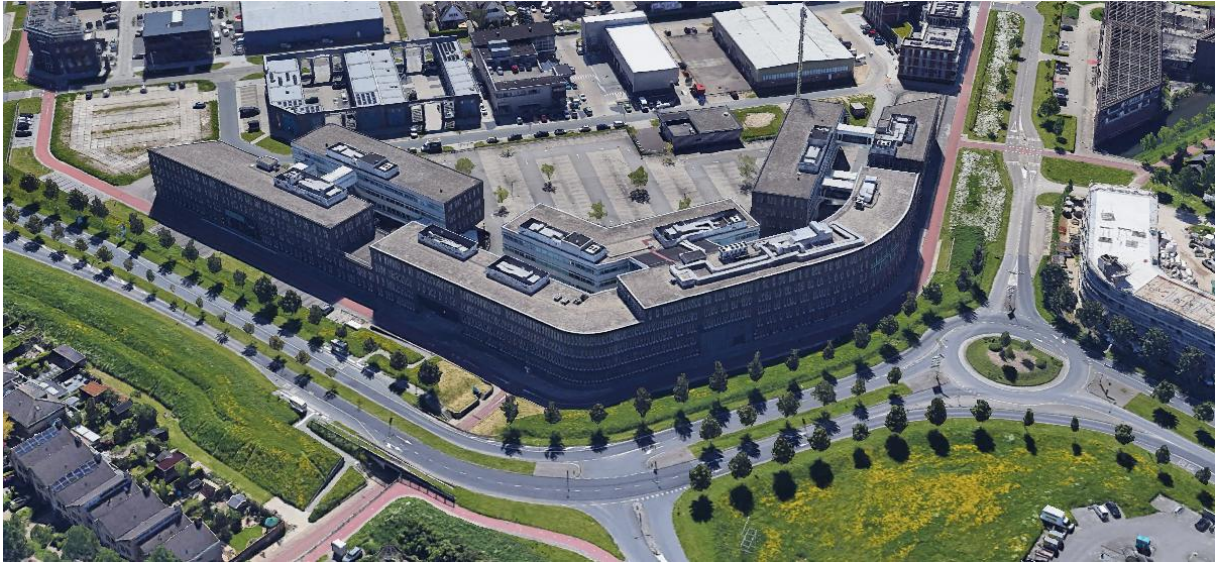
Afbeeldingen 2 & 3: luchtfoto's van weerszijden van het gebouw
