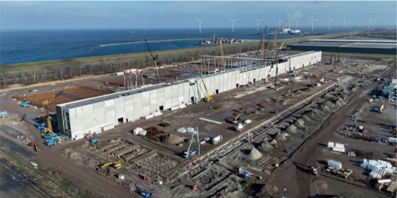
Figuur: aanbouw Flevokust haven
