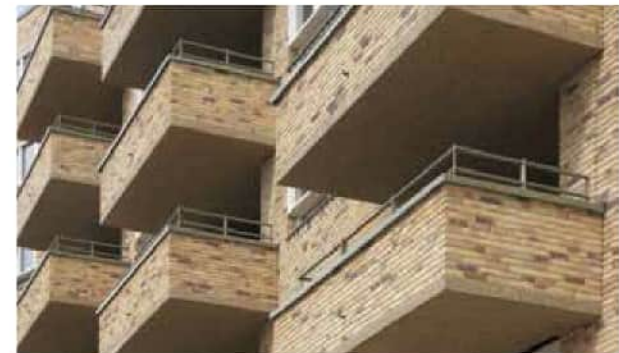
Combinatie van loggia en uitkragend balkon
