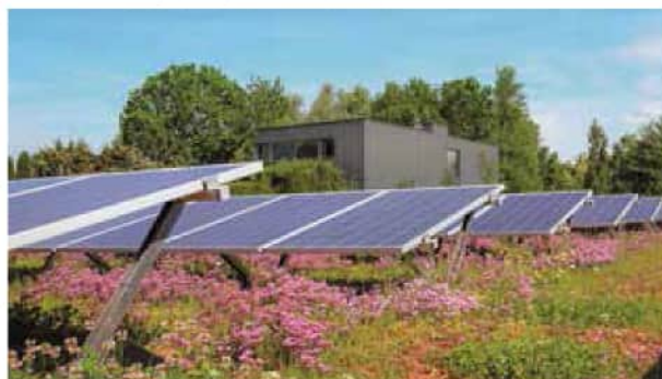
Groen dak met zonnepanelen
