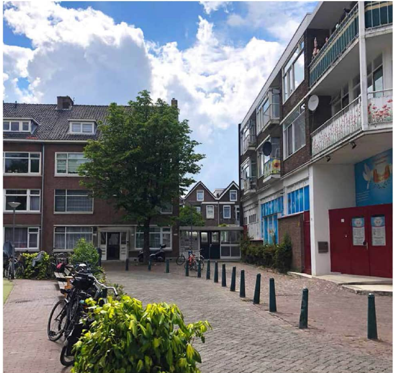
Overgang bestaande bouw naar aanpalende bebouwing in de zuidwesthoek
