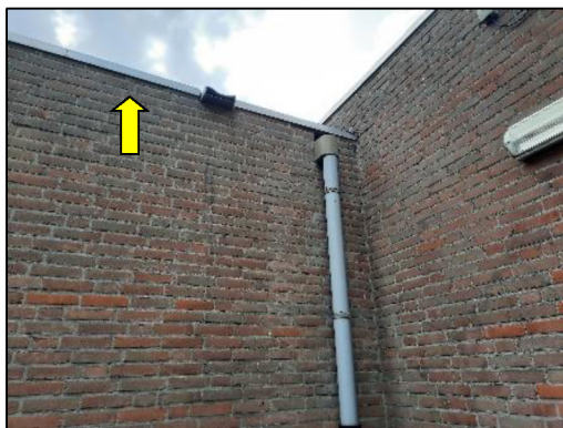
Figuur 11. Ruimte onder daklijst.
