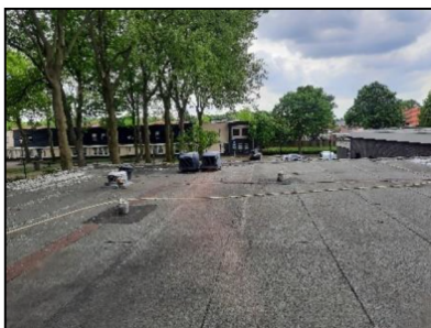
Figuur 6. Impressie bitumen plat dak van gemeenschapshuis.
