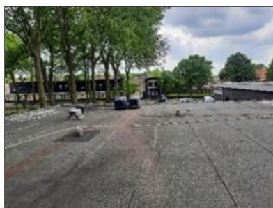
Figuur 2.6 Impressie bitumen platdak van gemeenschapshuis.
