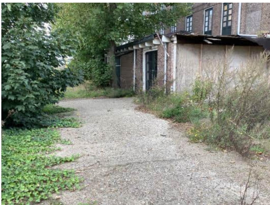
Zuidzijde van het terrein met het beton pad.
