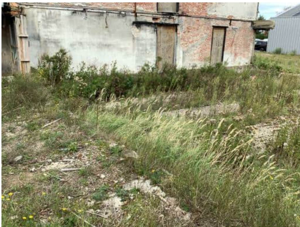
Fundering van de afgebrande loods
