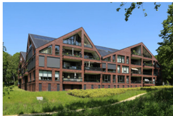
Karakteristiek appartementengebouw als ankerpunt van de wijk
