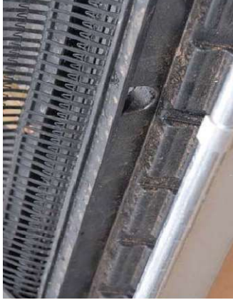
Figuur 19: De zogenaamde Vogelvide of vergelijkbare uitvoeringen geven wel mogelijkheid voor het maken van nesten, maar zorgt er voor dat er geen van buiten af door dieren bereikbare ruimten in gebouwen zijn (©Vogelbescherming Vlaanderen vzw).
