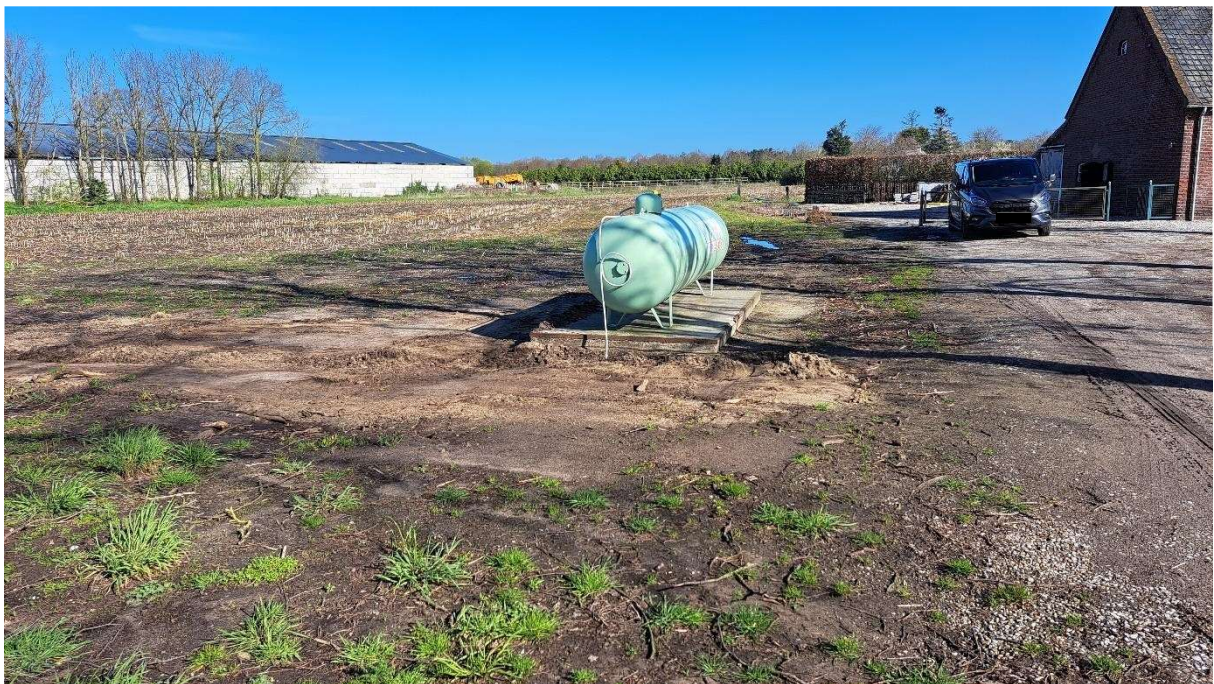
Rondom voormalige berging 4, bodem herschikt na sloop. Geen druppelzone meer aanwezig.
