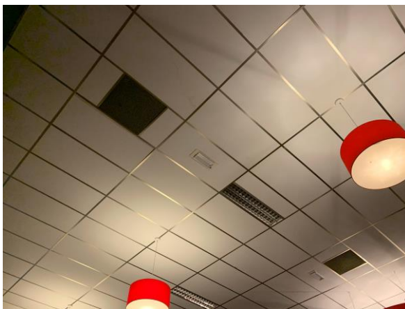
Foto 8-9: In de grote zaal en op het podium van de grote zaal is noodverlichting toegepast. Deze dient gehandhaafd en onderhouden te worden. Door een installateur dient gecontroleerd te worden of de vereiste verlichtingssterkte van 1 lux op vloerniveau wordt behaald.
