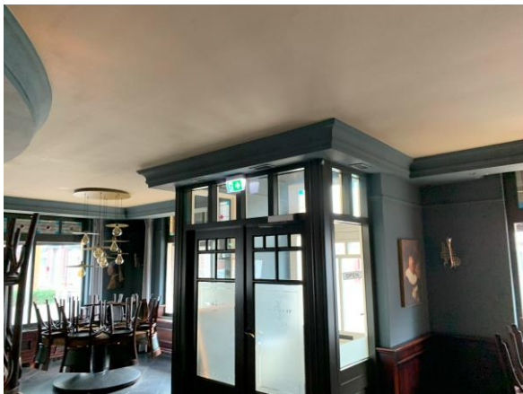
Foto 27: Dubbele deur naar entreesluis café. Dubbele deur heeft één draaiend deel en één vastgezet deel en draait met de vluchtrichting mee. De daaropvolgende buitendeur betreft een enkele tegen de vluchtrichting in draaiende deur. De deuren zijn voorzien van vluchtrouteaanduiding welke gehandhaafd en onderhouden moet worden.
