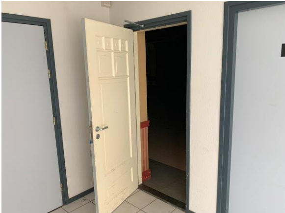
Foto 18-19: Enkele vluchtdeur vanuit kleine zaal naar entreeruimte. Deur draait met de vluchtrichting mee. Boven de deur is vluchtrouteaanduiding aanwezig welke gehandhaafd en onderhouden moet worden.
