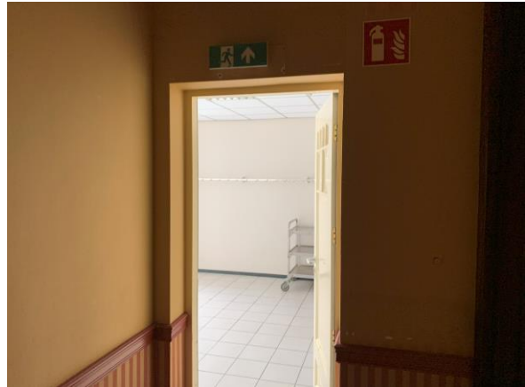
Foto 18-19: Enkele vluchtdeur vanuit kleine zaal naar entreeruimte. Deur draait met de vluchtrichting mee. Boven de deur is vluchtrouteaanduiding aanwezig welke gehandhaafd en onderhouden moet worden.
