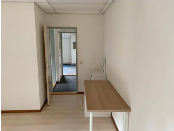
Foto 35-36: toegangsdeur voormalige bedrijfswoning vanuit bordes open trap. Vanuit de bedrijfswoning zijn twee vluchttrappen aanwezig welke beide in het café uitkomen. In de nieuwe situatie zal de bedrijfswoning niet meer als bedrijfswoning in gebruik genomen gaan worden, maar als ondersteunende ruimte aan de bijeenkomstfunctie gaan dienen (denk aan opslagruimte bijvoorbeeld). Hierdoor is het brandwerend afscheiden van de bedrijfswoning van de rest van het gebouw niet noodzakelijk. Dit blijkt bestaand ook niet aanwezig te zijn.
