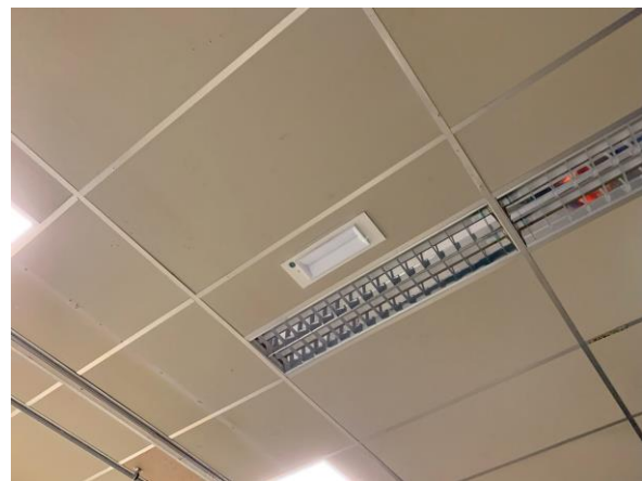
Foto 8-9: In de grote zaal en op het podium van de grote zaal is noodverlichting toegepast. Deze dient gehandhaafd en onderhouden te worden. Door een installateur dient gecontroleerd te worden of de vereiste verlichtingssterkte van 1 lux op vloerniveau wordt behaald.
