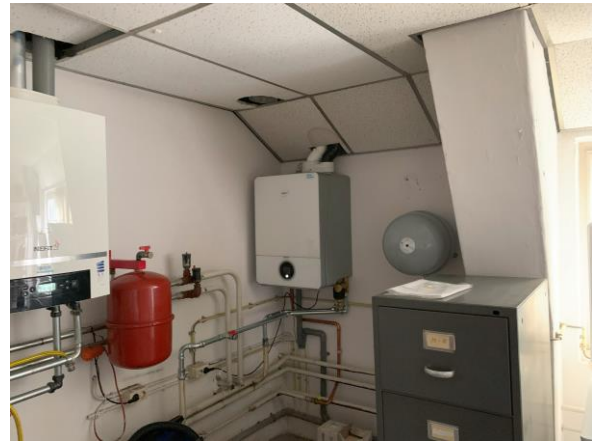
Foto 12-13: technische ruimte/ stookruimte welke toegankelijk is vanaf bordes boven aan de hellingbaan. Technische ruimte is kleiner dan 100 m 2 en derhalve gelegen in het brandcompartiment, maar hoeft niet als separaat brandcompartiment uitgevoerd te worden.
