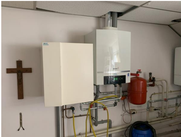
Foto 12-13: technische ruimte/ stookruimte welke toegankelijk is vanaf bordes boven aan de hellingbaan. Technische ruimte is kleiner dan 100 m 2 en derhalve gelegen in het brandcompartiment, maar hoeft niet als separaat brandcompartiment uitgevoerd te worden.
