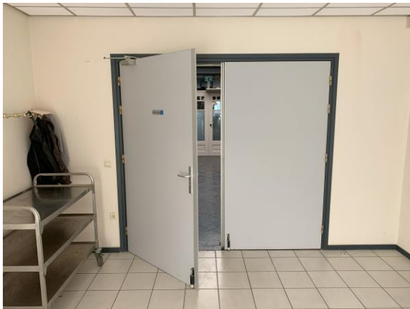
Foto 14-15: Dubbele vluchtdoor vanuit gang (grenzend aan café) naar entreeruimte. Beide deurhelften van de deur zijn te openen. Boven de deur is vluchtrouteaanduiding aanwezig welke gehandhaafd en onderhouden moet worden. De deur betreft een vluchtdoor vanuit de gang naar de entreeruimte.
