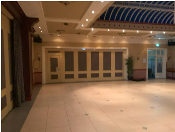
Foto 21: Flexibele wand in kleine zaal met enkele deur. Deur is niet aangewezen als vluchtdeur vanuit de kleine zaal. Naast de flexibele wand is een dubbele vluchtdeur aanwezig, waarvan één helft te openen is bij een calamiteit en de andere helft is vastgezet met een vastzetinrichting. De vluchtdeur komt uit in een sluis waarna de entreehal kan worden bereikt.
