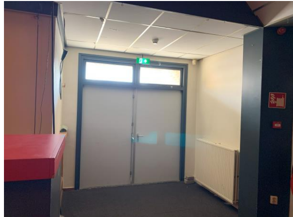
Foto 3-4: Twee keer dubbele vluchtdeur rechtstreeks naar aansluitend terrein vanuit de grote zaal. Deuren zijn links en rechts van het bargedeelte gepositioneerd. Beide deurhelften van de deuren zijn in geval van een calamiteit te openen door middel van de toegepaste sluiting. Boven de deuren is vluchtrouteaanduiding toegepast. Deze vluchtrouteaanduiding handhaven en onderhouden.
