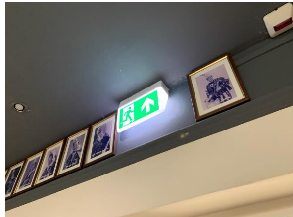
Foto 14-15: Dubbele vluchtdoor vanuit gang (grenzend aan café) naar entreeruimte. Beide deurhelften van de deur zijn te openen. Boven de deur is vluchtrouteaanduiding aanwezig welke gehandhaafd en onderhouden moet worden. De deur betreft een vluchtdoor vanuit de gang naar de entreeruimte.
