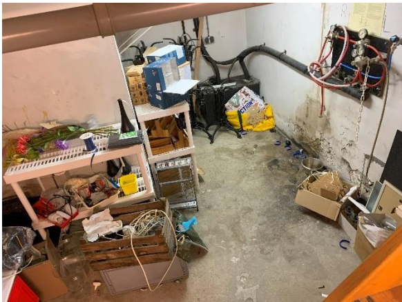
Foto 37-38: Foto bestaande situatie kelder. De kelder betreft een opslagruimte en is bereikbaar via een vaste trap vanuit het café (achterzijde bar).
