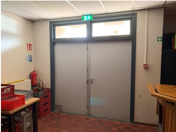
Foto 3-4: Twee keer dubbele vluchtdeur rechtstreeks naar aansluitend terrein vanuit de grote zaal. Deuren zijn links en rechts van het bargedeelte gepositioneerd. Beide deurhelften van de deuren zijn in geval van een calamiteit te openen door middel van de toegepaste sluiting. Boven de deuren is vluchtrouteaanduiding toegepast. Deze vluchtrouteaanduiding handhaven en onderhouden.
