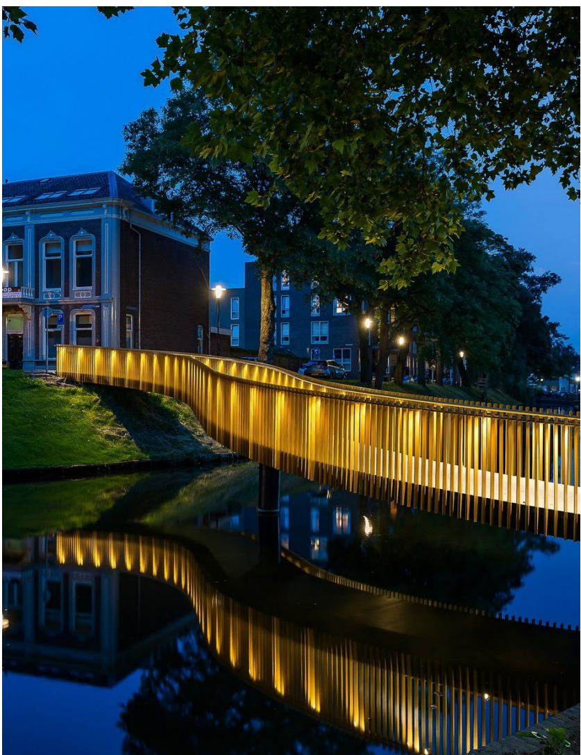
Aanlichten stalen bruggen vanuit spot op bestaande lichtmast
