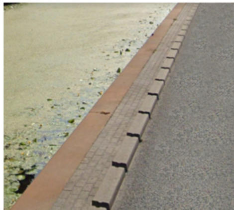
Onderbroken verhoogde trottoirband langs kade
