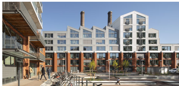
Wilhelminawerf | Utrecht | Dok architecten: Duidelijke plint, gevarieerd volumeopbouw en industrieel karakter
