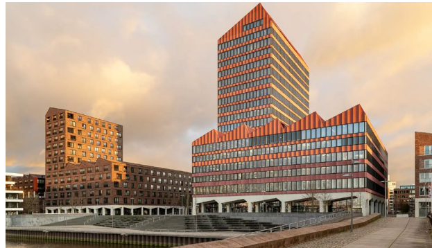
Europahafenkopf | Bremen | COBE: Verdeling in plint, lijf en kroon. Speelse dakvorm hint naar industrieel verleden
