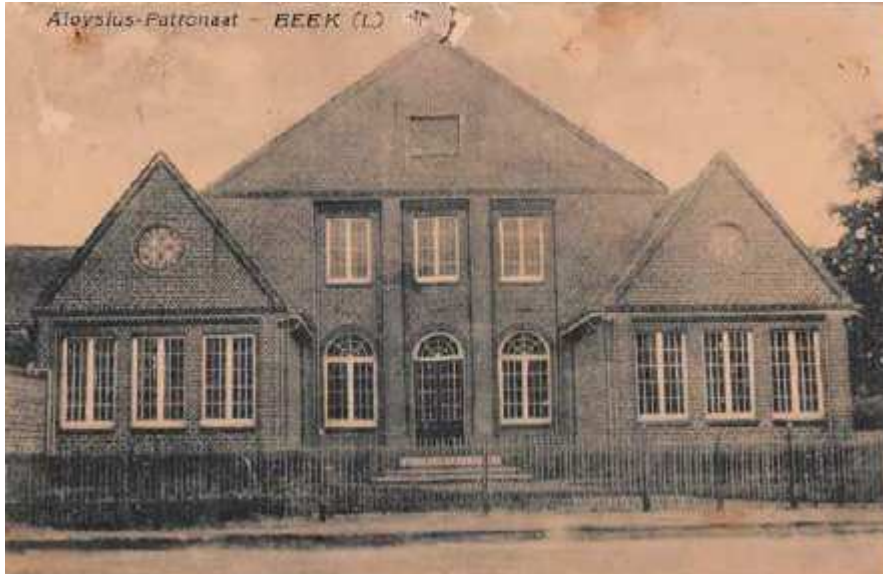
Patronaatsgebouw omstreeks 1915 (bron: bouwhistorisch onderzoek C. Eggen, april 2019)
