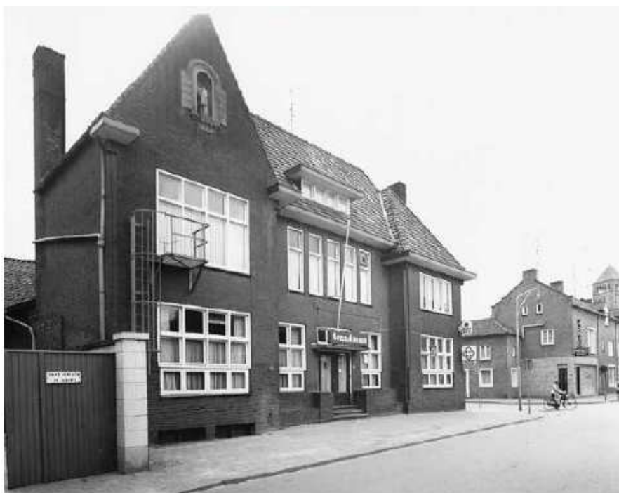
Patronaatsgebouw omstreeks 1975 (bron: bouwhistorisch onderzoek C. Eggen, april 2019)
