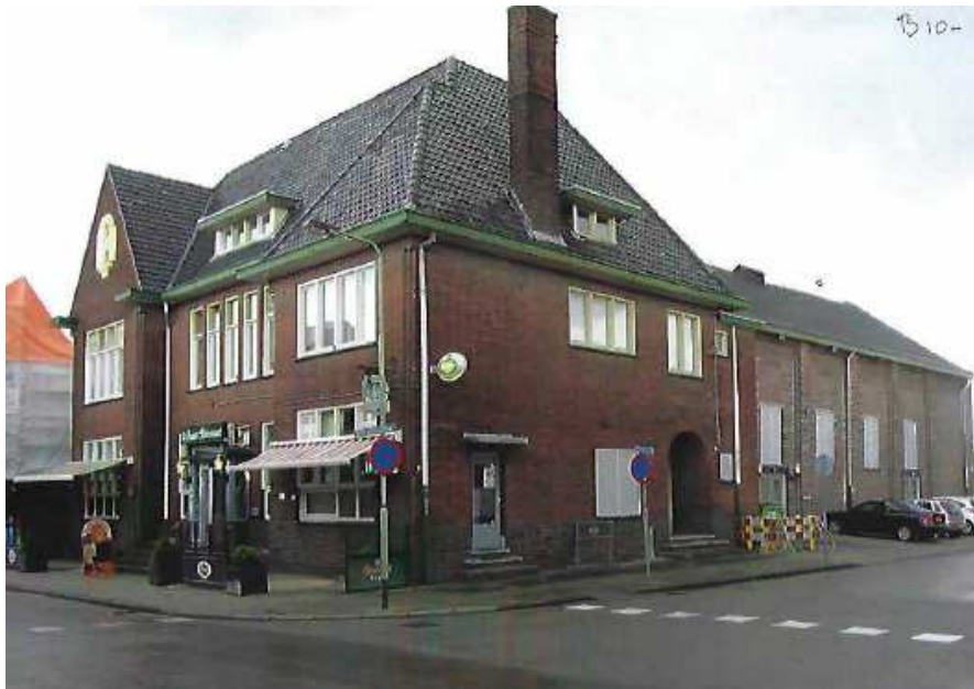
Patronaatsgebouw omstreeks 2005 (bron: bouwhistorisch onderzoek C. Eggen, april 2019)
