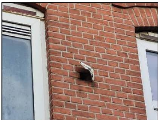
Afbeelding 4: Opening in de muur
