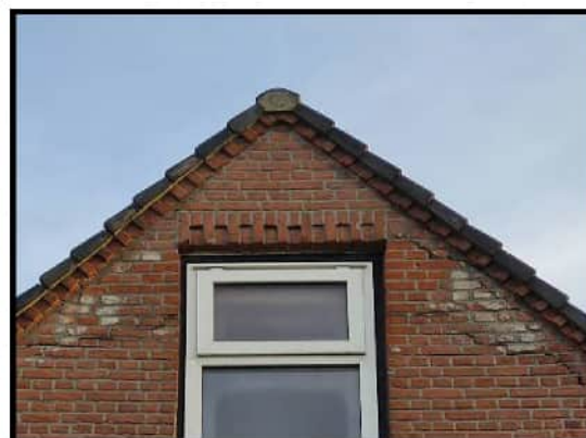
Afbeelding 5: Ruimte achter dakpannen
