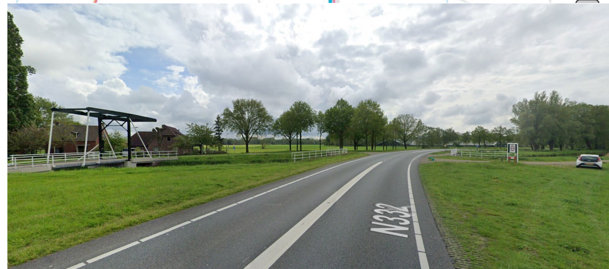
Rust ter hoogte van Ramelerbrug / N332
