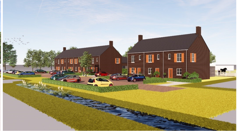
Rijwoningen vanuit het noordoosten
