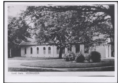
De Gereformeerde Kerk te Veenhuizen. 1920-1940. Bron: DM0216031301, Drents Archief.
