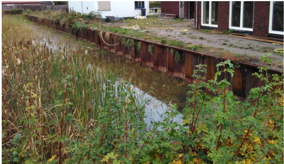
Bergingsvijver 212 in 2016 (nieuwbouw in aanleg)
