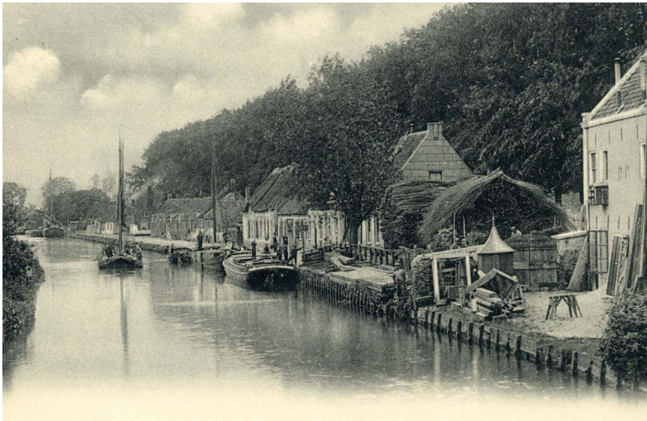
Gezicht over de Hollandse IJssel te IJsselstein, met rechts de huizen langs de Panoven (Het Utrechts Archief, 1900)
