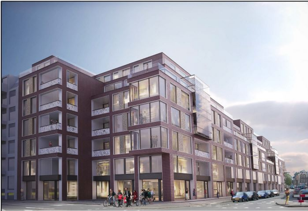
Impressie Kaatstraat 1 na transformatie
