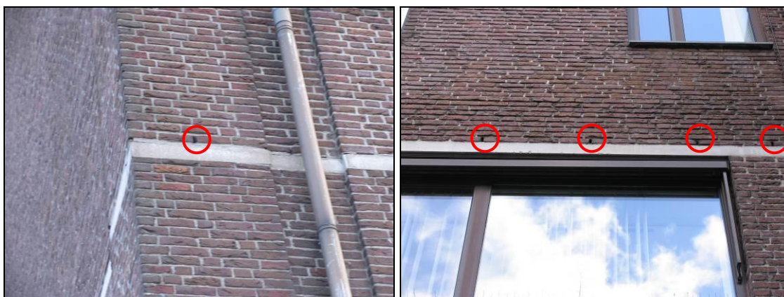
Open stootvoegen (rood omcirkeld) in de gevel van het pand geven mogelijk toegang tot de spouwmuur waarin vleermuizen een verblijfplaats kunnen hebben. Foto's SAB (2014).
