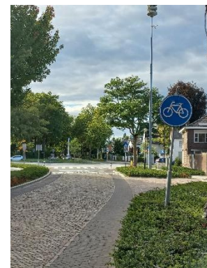
Bord fietspad verkeerd geplaatst
