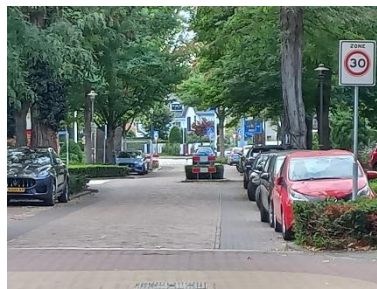
Voorbeeld bord zone 30 verkeerd geplaatst
