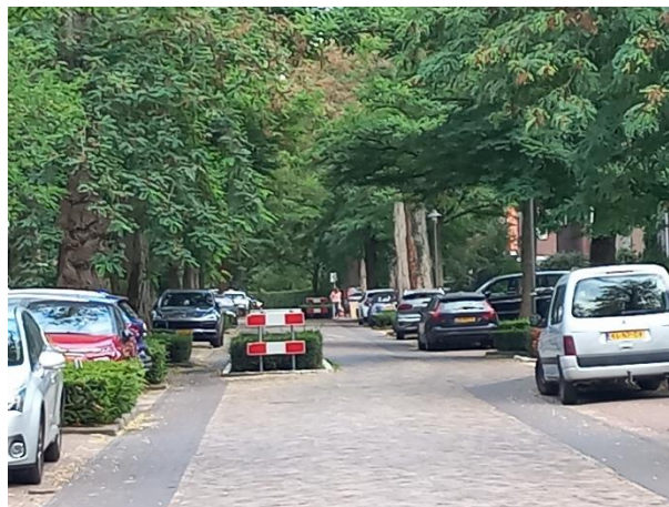
Figuur 4: wegversmalling, rechte rijlijn wordt onderbroken
