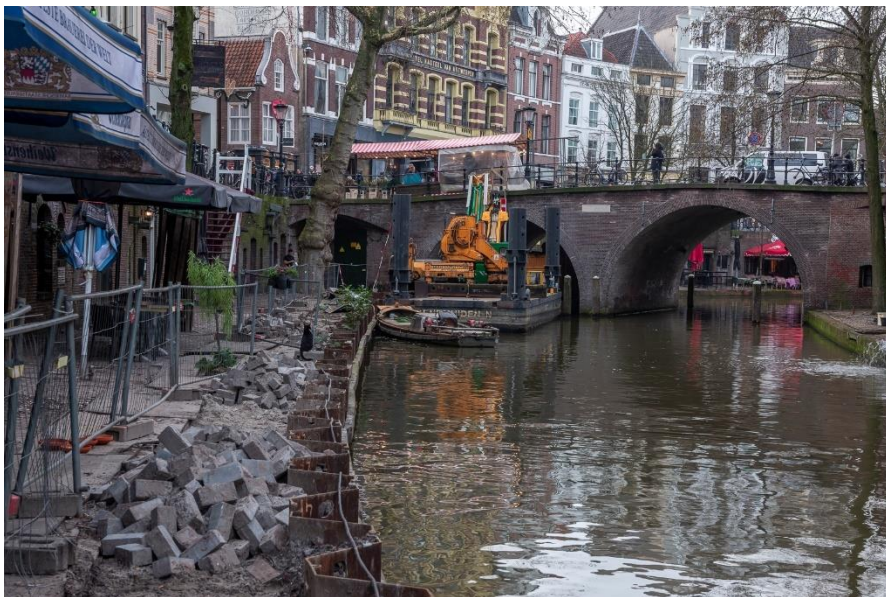
Herstel Oudegracht tussen Bezembrug en Bakkerbrug
