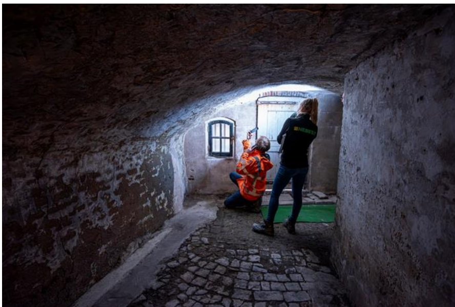
Inspectie in een werfkelder
