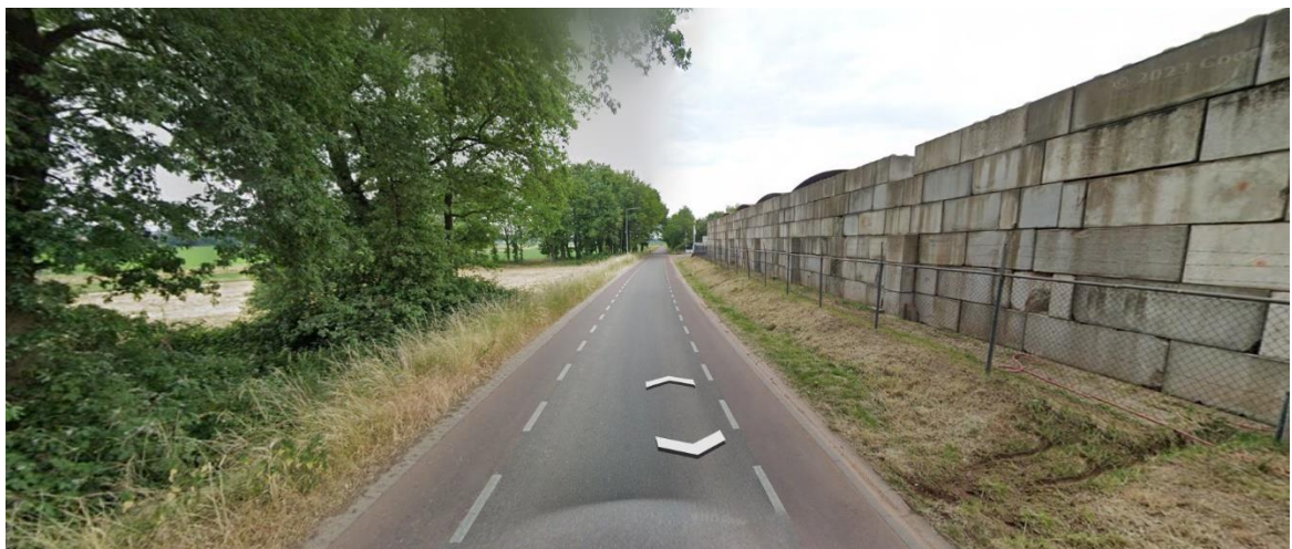
Afbeelding 6: Bestaande situatie keerwanden gezien vanaf de St. Jorisstraat in noordelijke richting
