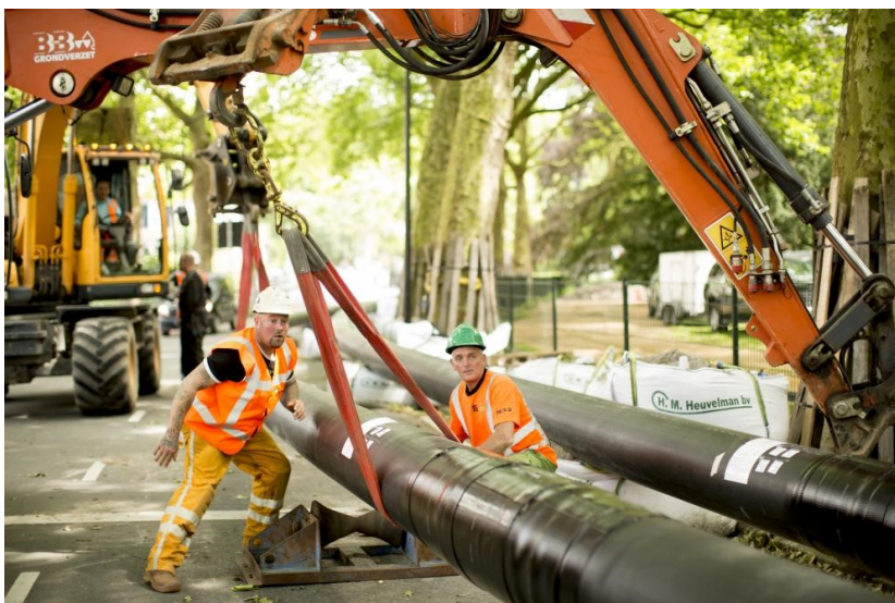
Aanleg warmtenet Dordrecht
