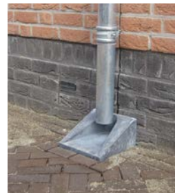
Zichtbare afkoppeling hemelwater afvoer.
