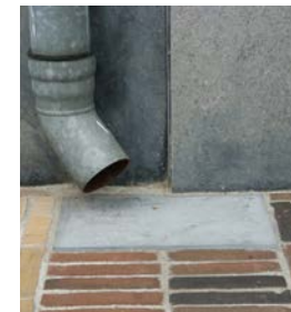
Zichtbare afkoppeling hemelwater afvoer.
