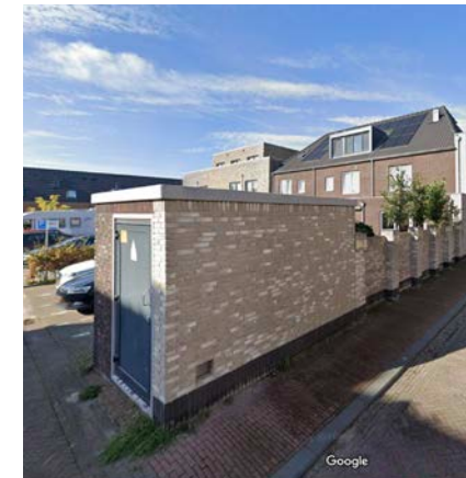
Technische ruimte in bouwblok.
