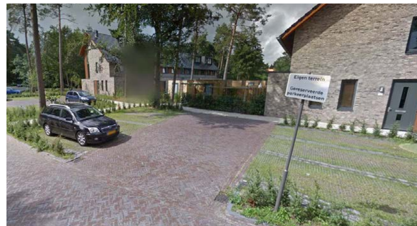
Referentie parkeerhof met grasbetontegels.
