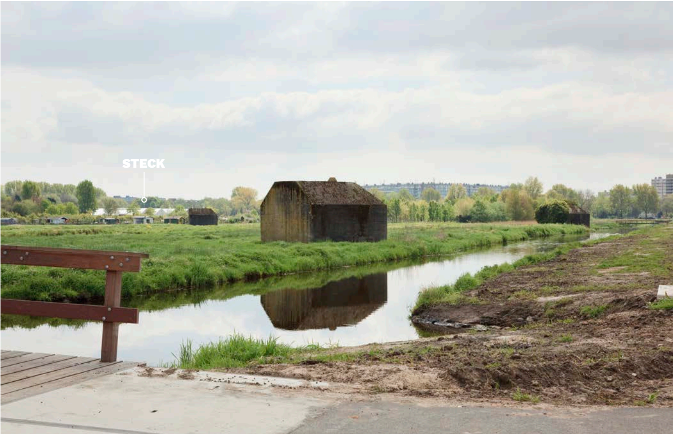
Afbeelding vanuit het Noorderpark en de tussenstelling Gagel-Ruigenhoek met op de achtergrond de locatie Steck en de stad Utrecht. Bron: collectie Rijksdienst voor het Cultureel Erfgoed, Obj. nr. 546.267
