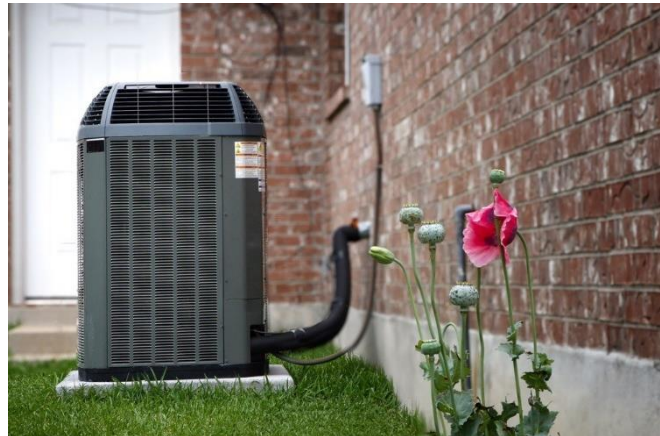
Figuur 6 De buitenunit van een warmtepomp; in combinatie met goede isolatie een duurzaam alternatief voor een CV-ketel
