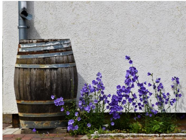
Figuur 11 Een regenpijp die is afgekoppeld van het riool. Regenwater vloeit naar een regenton zodat het hergebruikt kan worden.
