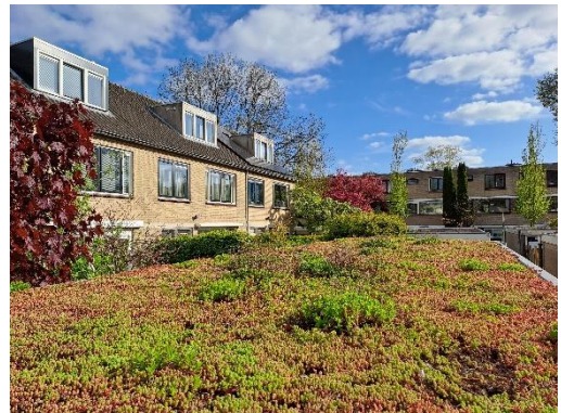
Figuur 1 Bepanting op het dak van een schuurtje (sedum dak). Een goed voorbeeld van toekomstbestendig en duurzaam bouwen
