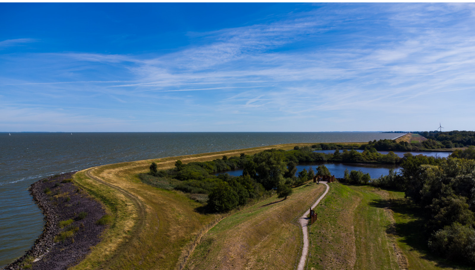
Zicht op monument Gat in de dijk
