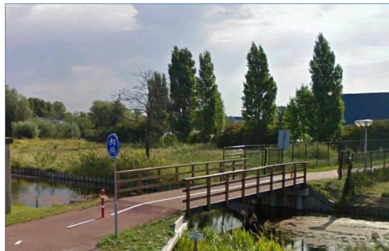
Houten fietsbrug in fase I
