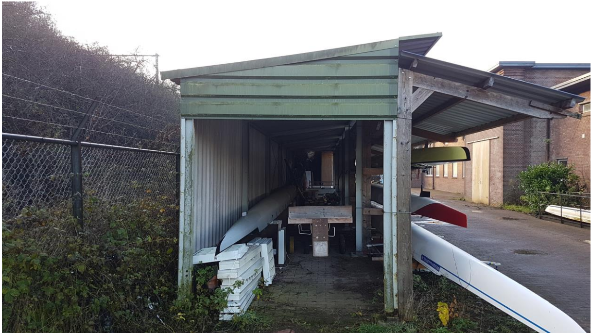
Foto 7: de te slopen overkapping achter het voormalige PGEM-gebouw.
