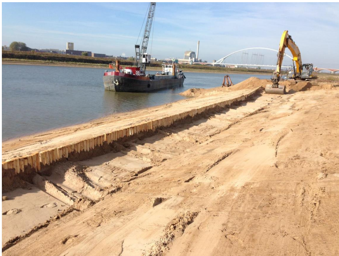
Figuur 2. Het begin van de werkzaamheden om de oever te versterken, de werkzaamheden zijn in oktober 2018 afgerond.
