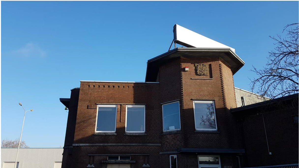
Foto 1: voormalige PGEM gebouw waar nu de roeivereniging is gevestigd.
