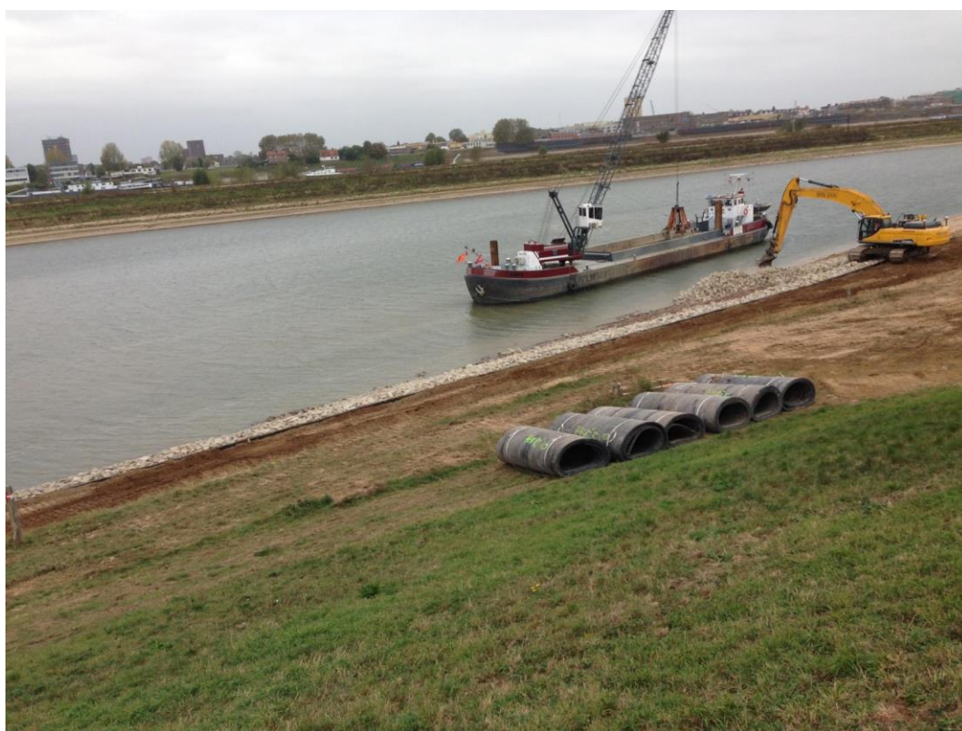
Figuur 4. Op het doek is naderhand breuksteen aangebracht.
