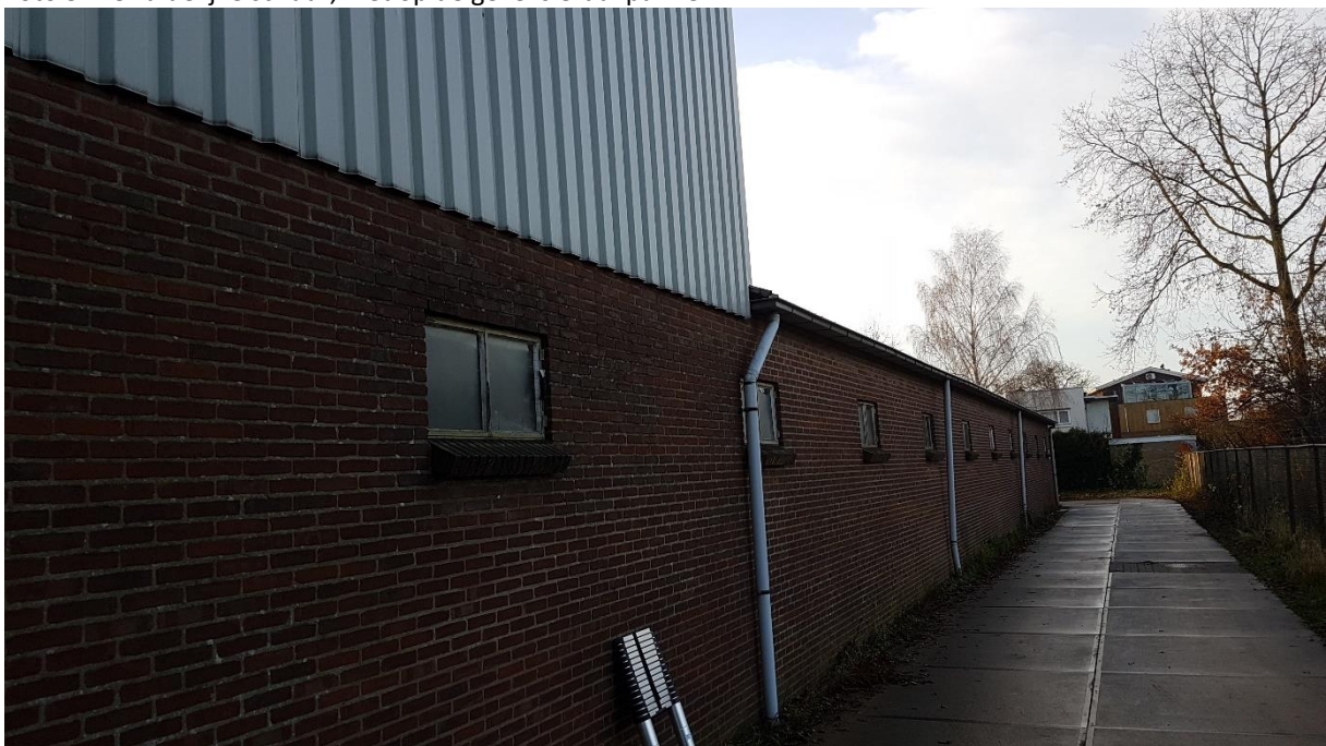
Foto 4: de overgang van de zuidelijke schuur (rechts in de noordelijke schuur (Links met metalen golfplaat), de betonplaten is de nieuwe aangelegde weg voor het nieuwbouw project ten noorden van het plangebied.
