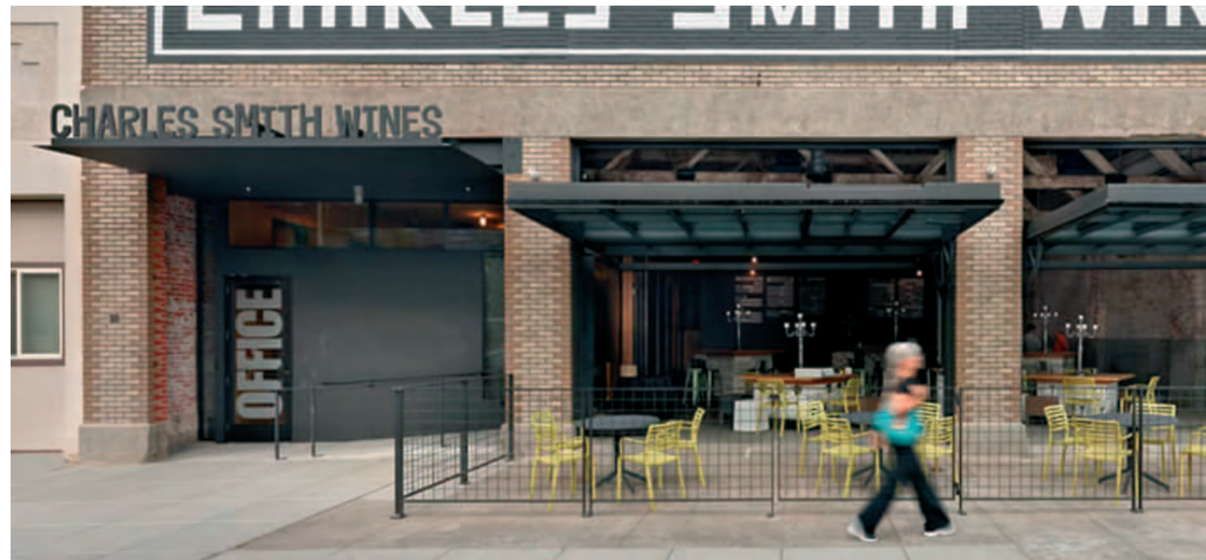
Technische ruimtes geïntegreerd in de gevels
