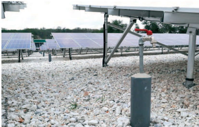
Solardak met laag absorberend substraat
