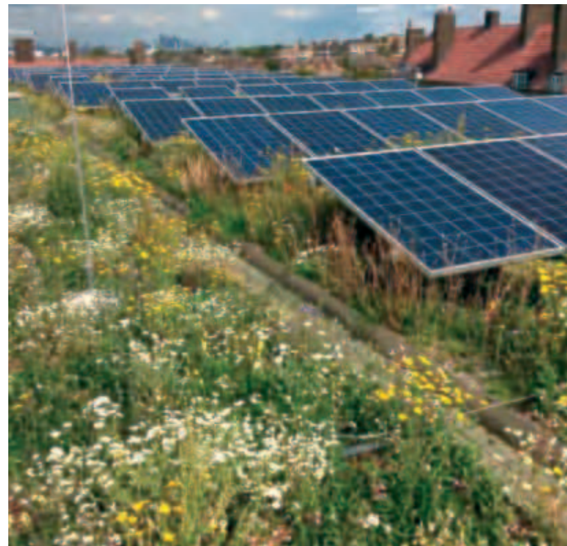
Groene daken in combinatie met PV-panelen
