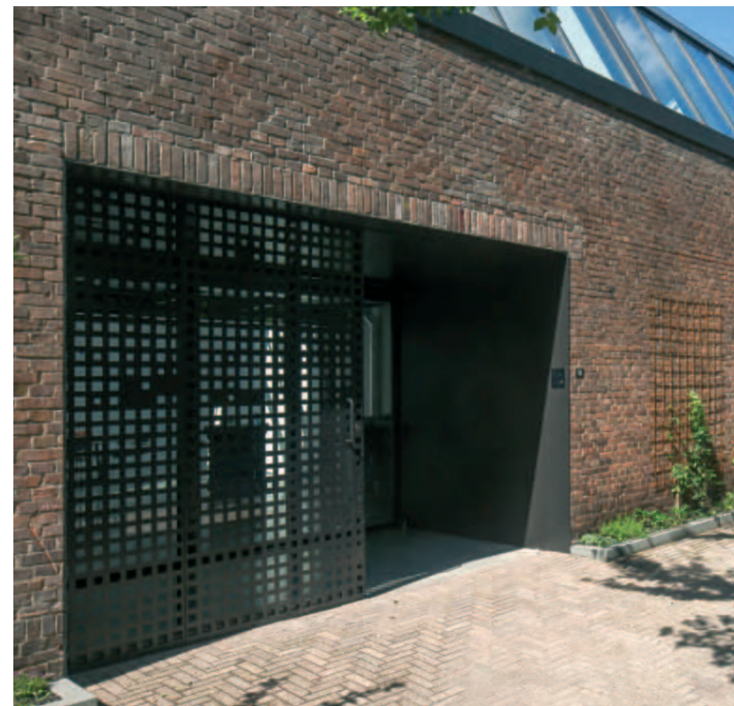
Technische ruimtes onderdeel van de architectuur
