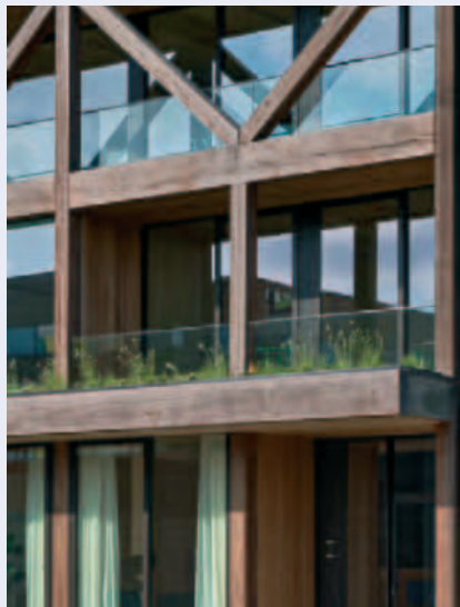
houtbouw refereert aan de werkplaats
