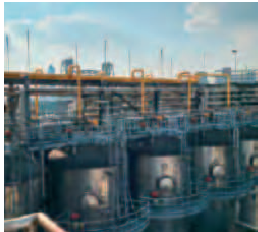
Pijpen en silo's
