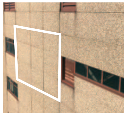
prefab betonnen platen
