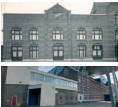
gevel met grote ramen
