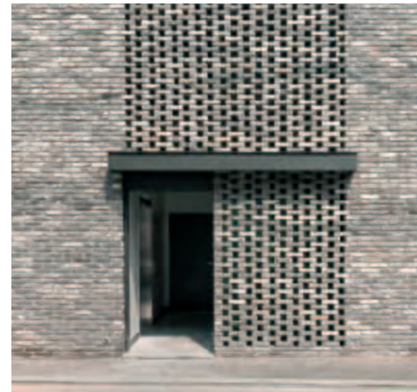
Techniek inpandig oplossen
