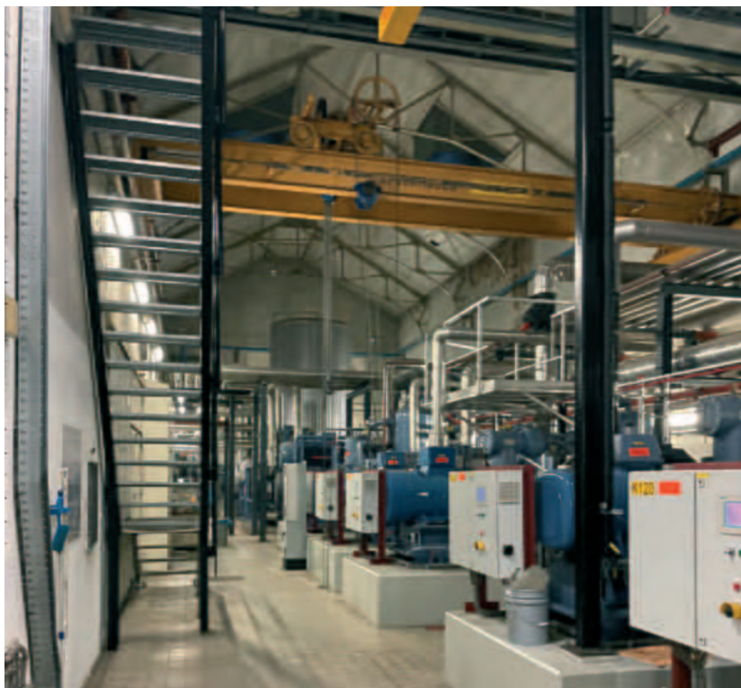
Ketelhuis en werkplaats
