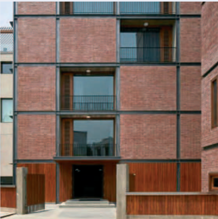
staalframe en metselwerkgevel invulling
