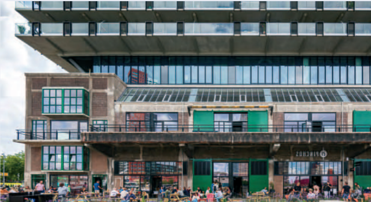
luifel en gebruikruimte aan de kade. Levendigheid aan de waterkant van de fabriek
