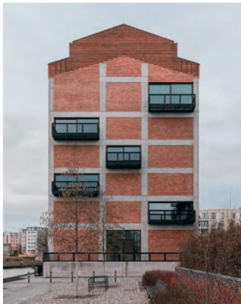
Constructie in het zicht
