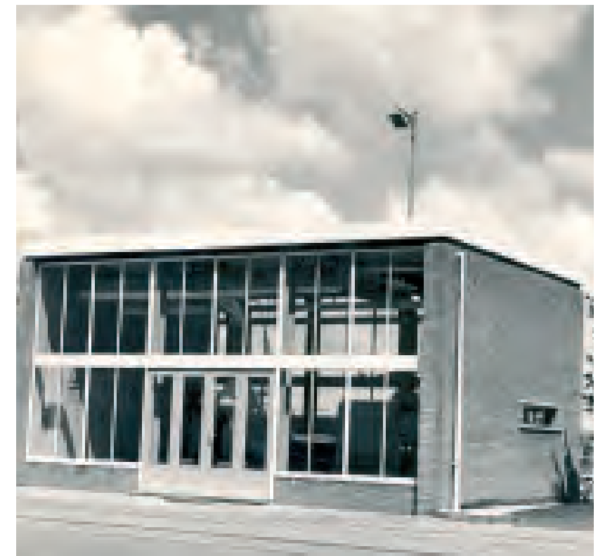
Herbestemming van waterpompgebouw
