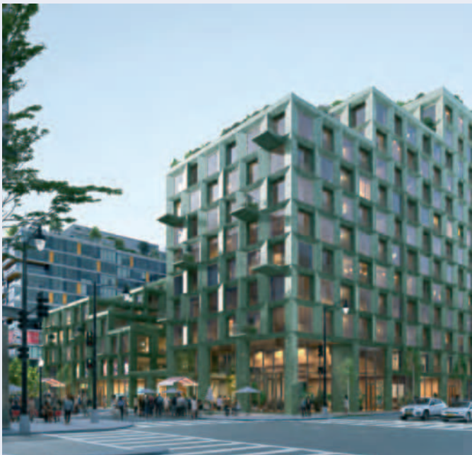
getrapte opbouw van terrassen richting het water
