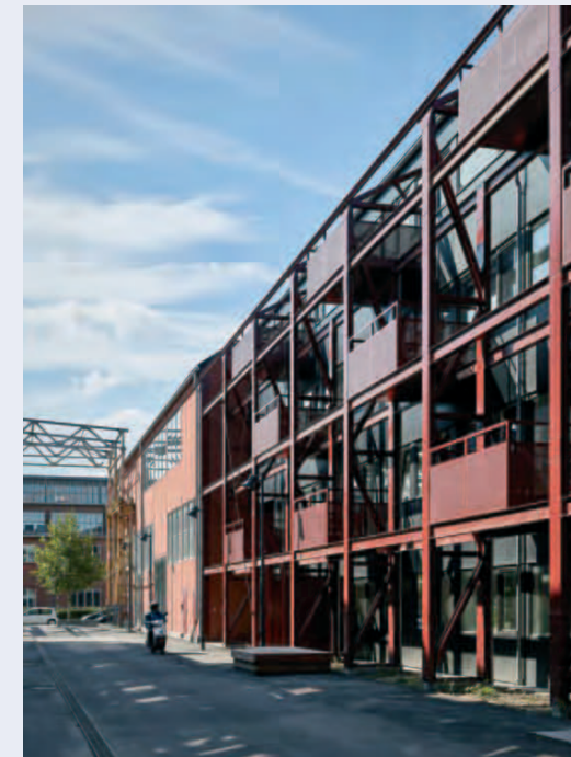
stalen trappen en corridor
