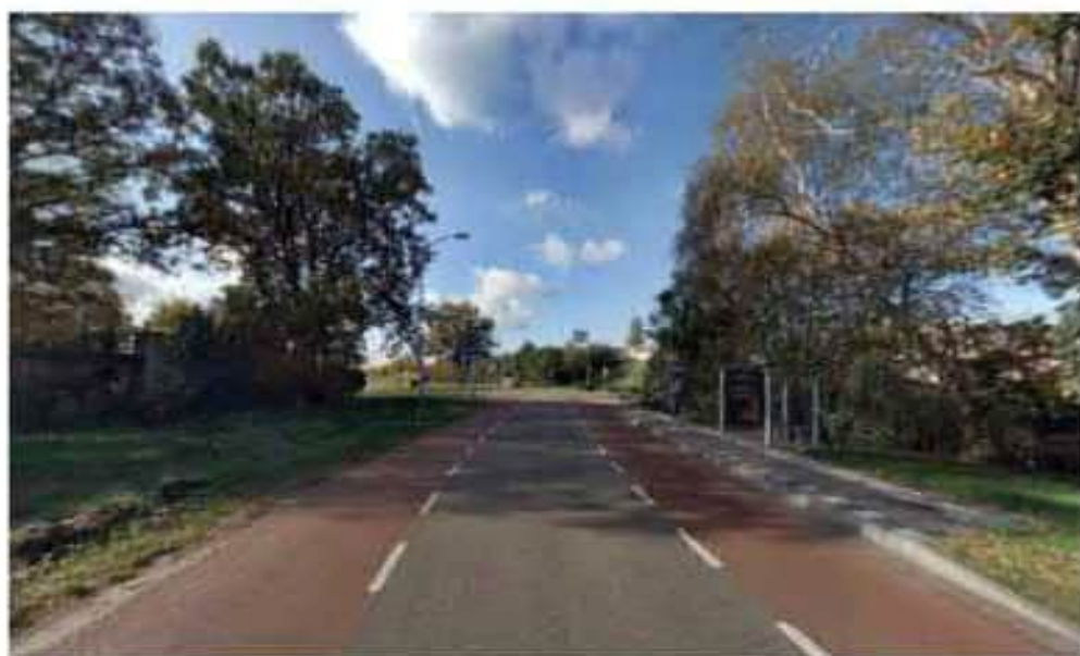
Figuur: 4.4: Huidige situatie Bosschebaan (bron: Cyclomedia).
