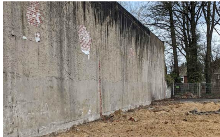
Westzijde van de muur in huidige situatie
