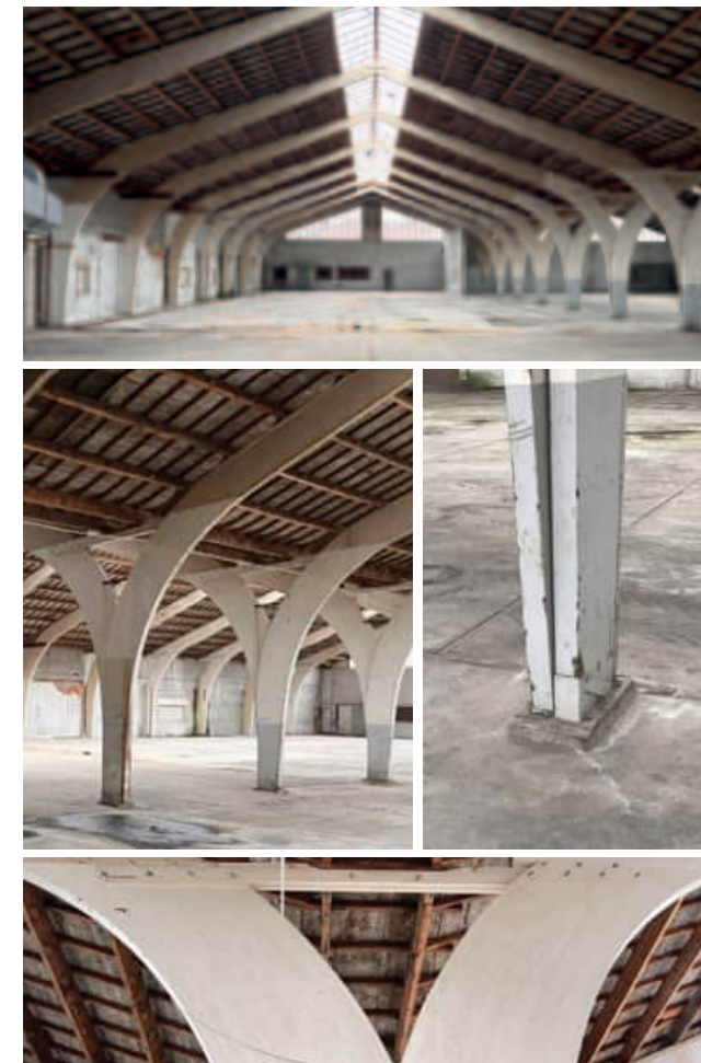
De spanten in de huidige staat
