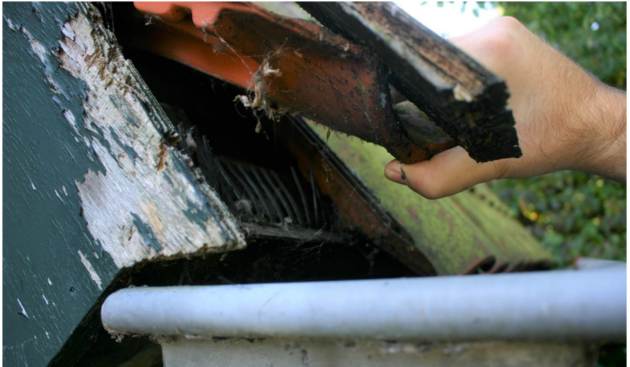
Figuur 4.4.1. Onder de onderste rij dakpannen van de schuur zit degelijk vogelschroot. Hierdoor kunnen huismussen niet onder deze pannen nestelen.
