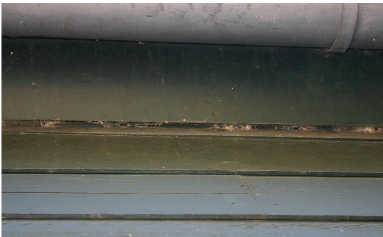
Figuur 4.4.3. De houten wandbetimmering sluit overall nauw aan. Hier kunnen geen vleermuizen naar binnen.
