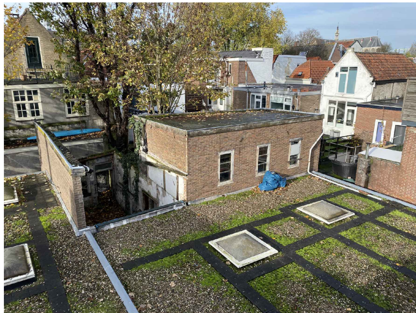
Gebouw G gezien vanaf dak Tuinstraat 16-22
