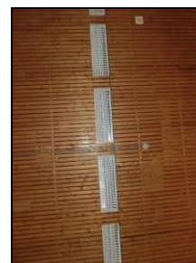
Houten schroten plafond
