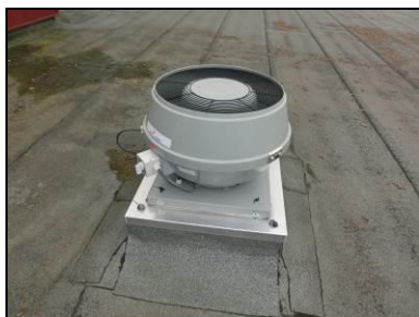
Vernieuwde afzuigventilator
