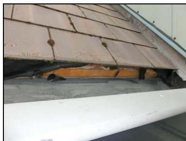
Opbouw schuine dakvlakken met asbest leien
