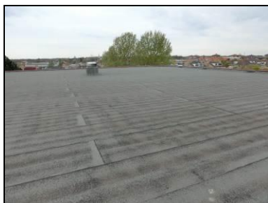
Dakbedekking hoge dakvlak
