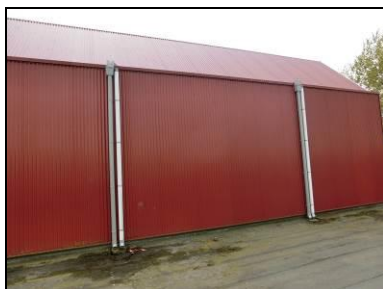
Hemelwaterafvoeren sporthal
