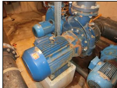
Defecte fundatiepomp
