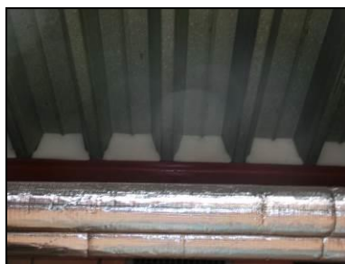
Geïsoleerde cannelures
