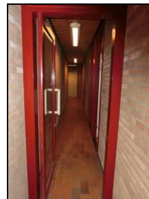
stalen kozijn en (brand)deur
