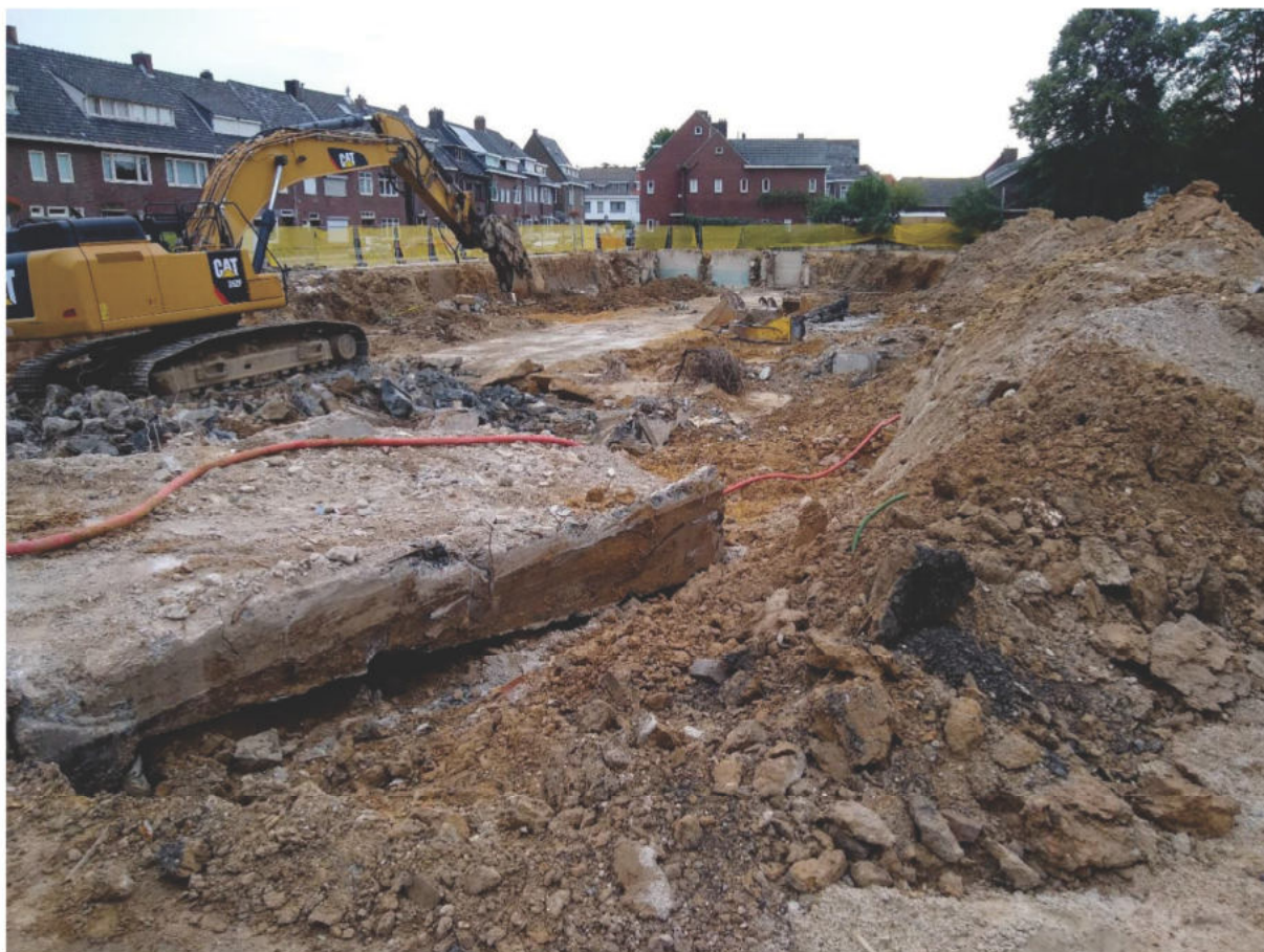
Figuur 2. Overzichtsfoto van de sloopwerkzaamheden, gezien in noordelijke richting.
