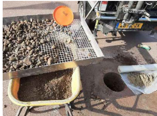
Omschrijving: Boorpunt A02
