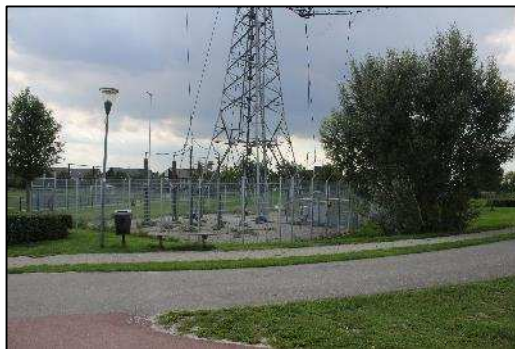
Figuur 4.2. Intredepunt nabij mast 12.
