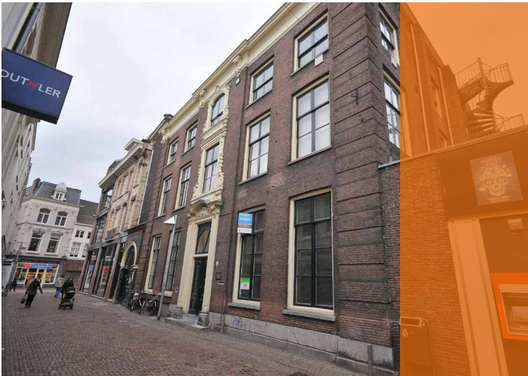
Mariëburgstraat 12/13 • pand getransformeerd van maatschappelijke doeleinden naar appartementen.
