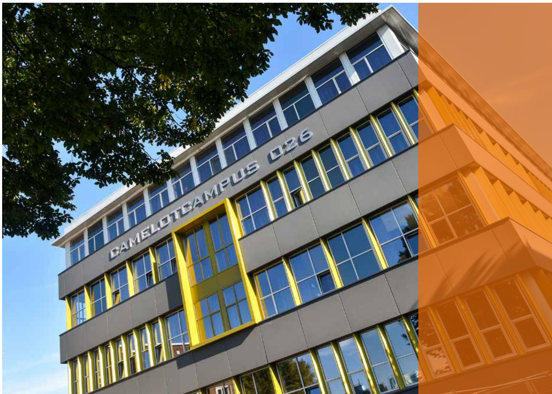
Eusebiusplein 1 • oud kantoorpand (voormalig UWV - vestiging) verbouwd tot appartementencomplex.
