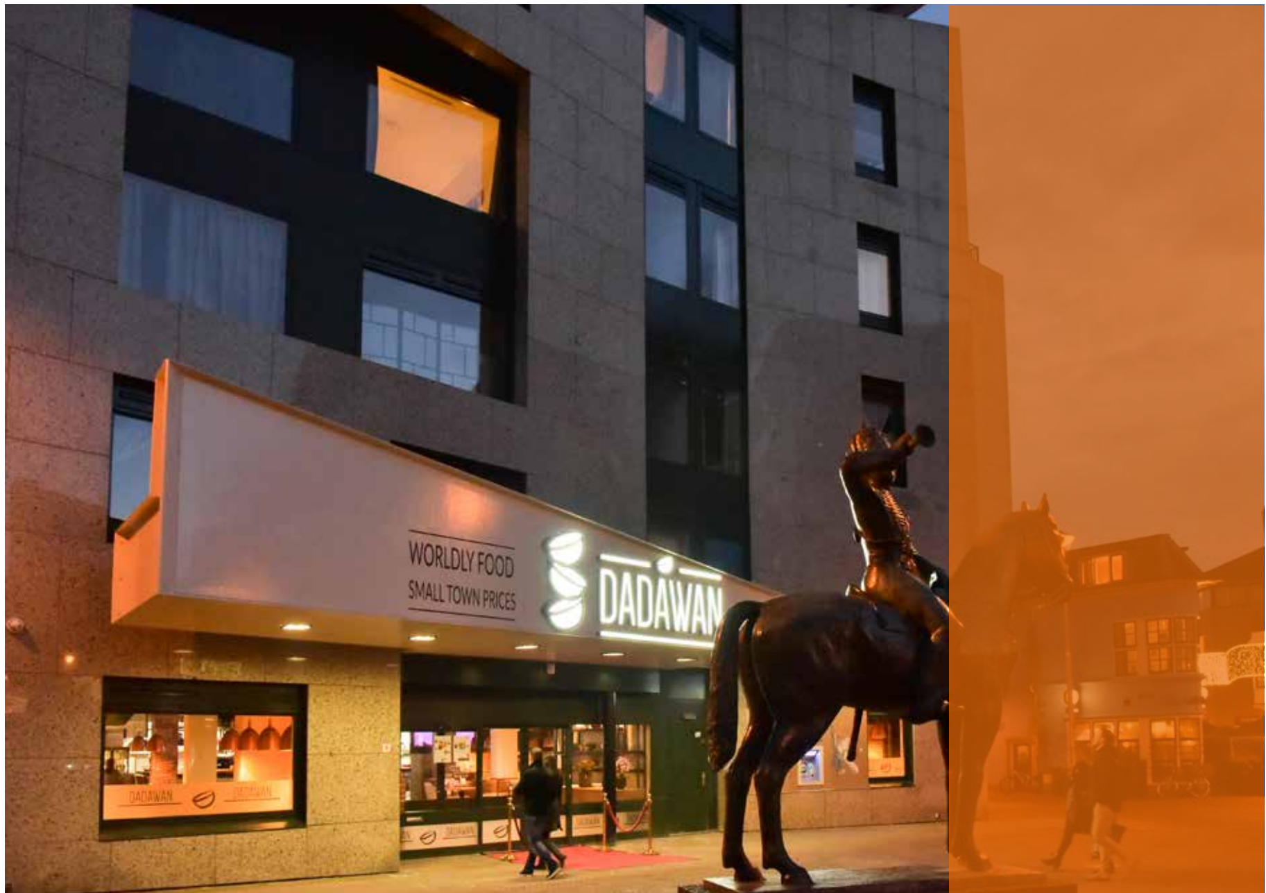
Gele Rijdersplein 15 • getransformeerd van kantoor naar mix van wonen en horeca.
