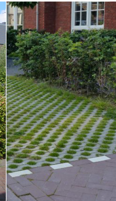
Parkeervakken in grasbeton
