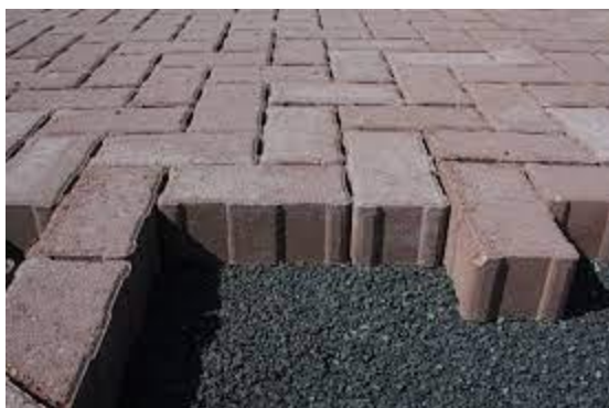
Figuur 4 Waterpasserende verharding
