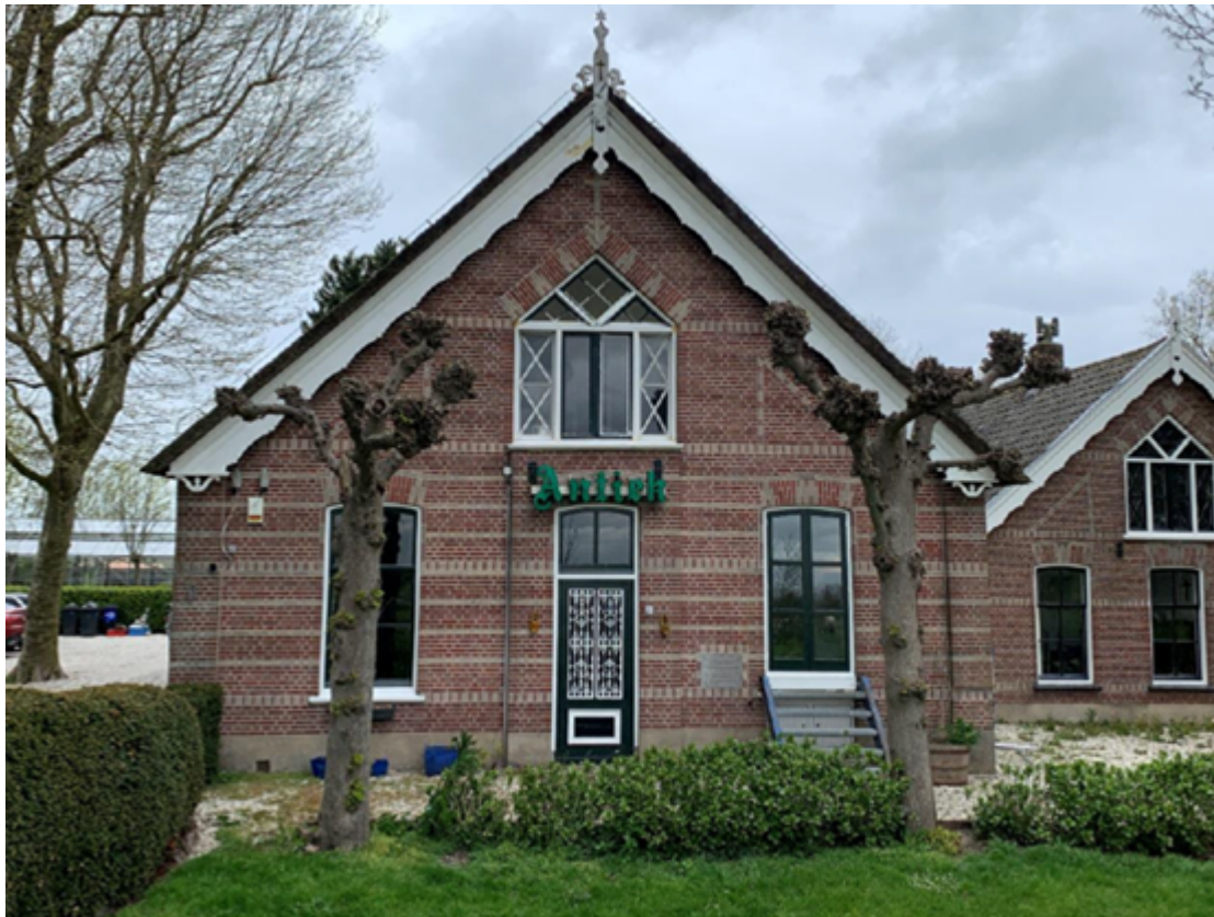
Afbeelding: voorgevel monumentale boerderij
