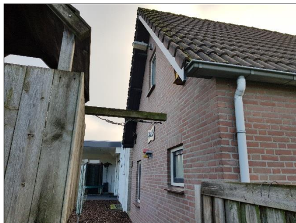
Figuur 7. Te slopen bijgebouw
