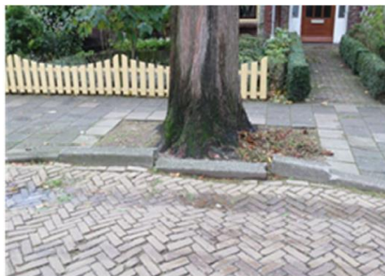
Wortelopdruk bij onvoldoende ondergrondse groeiruimte
