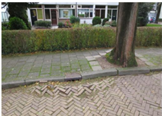
Wortelopdruk bij onvoldoende ondergrondse groeiruimte
