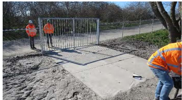
34 Toegangshek tpv opstelplaats
