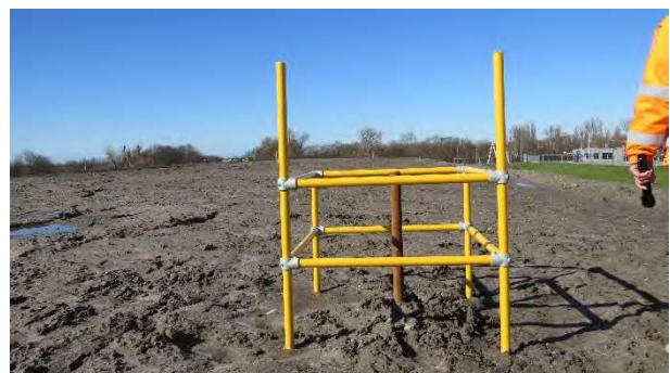
56 Zekbaken met beschermend framewerk
