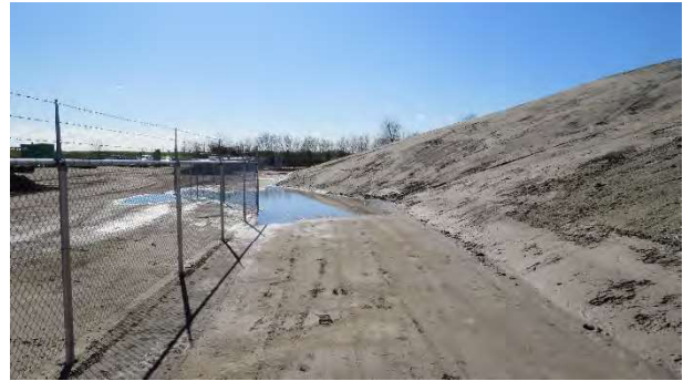
50 Betonpad oostzijde locatie
