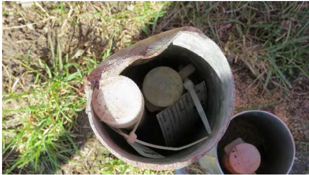
27 Peilbuizen tpv M3.1, 3.2, 3.3 en 3.4 met beschadigde beschermkoker
