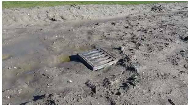
10 Hemelwaterverzamelput bovenzvlak
