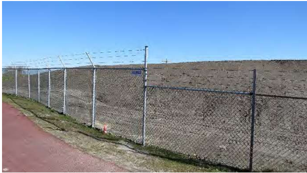
35 Hekwerk westzijde locatie, met overgangspunt nieuw naar oud hekwerk
