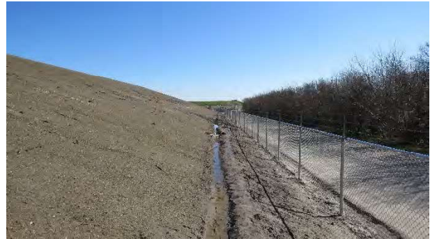
38 Hekwerk zuidzijde locatie
