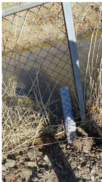
44 Overstroomleiding infiltratiesloot
