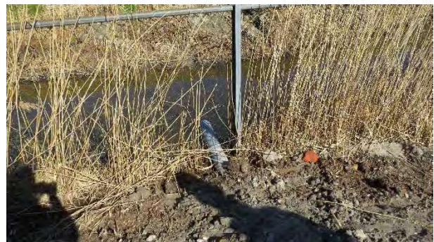
42 Overstroomleiding infiltratiesloot
