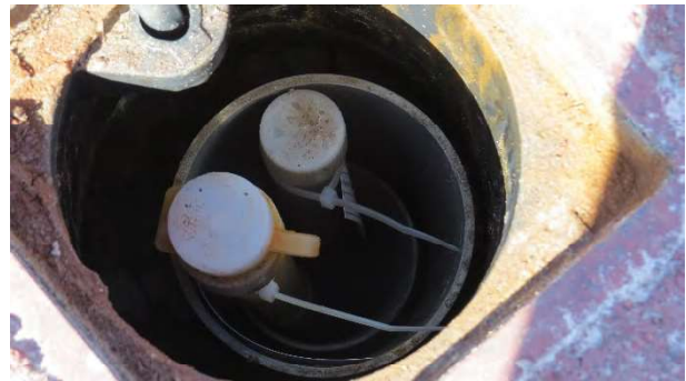
30 Peilbuizen M2.1 en M2.2
