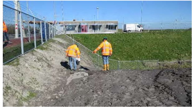
36 Hekwerk west- en noordzijde locatie, met overgangspunt nieuw naar oud hekwerk
