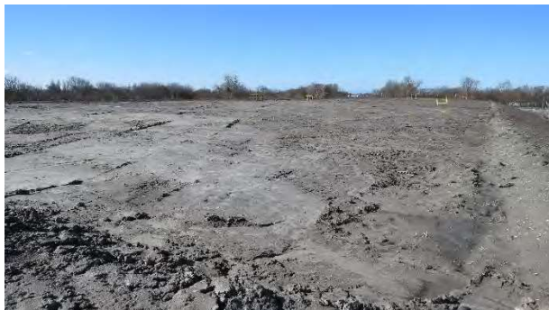
1 Deklaag bovensvlak depot
