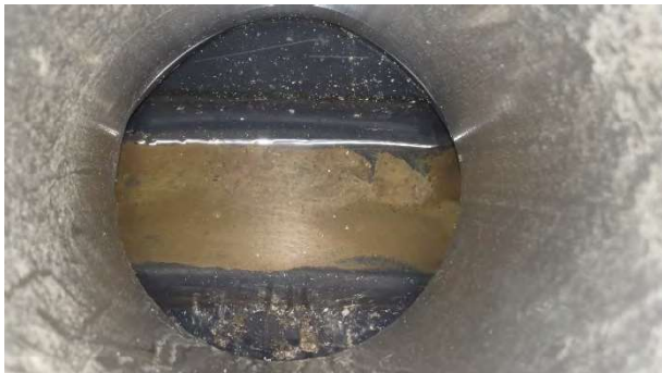
7 Doorstroming in hemelwaterverzamelput
