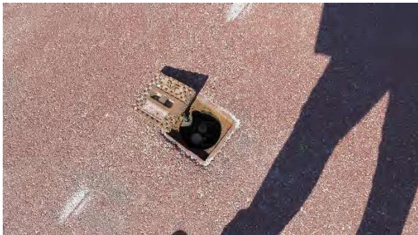
29 Peilbuizen M2.1 en M2.2
