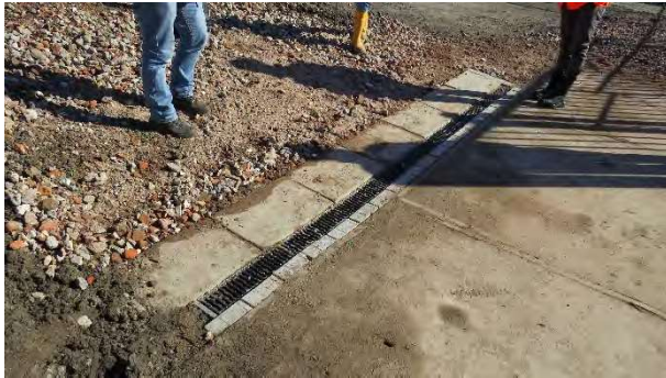
21 Verzamelgoot onder aan de hellingbaan
