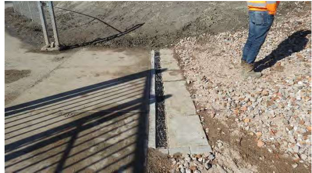
22 Verzamelgoot onder aan de hellingbaan
