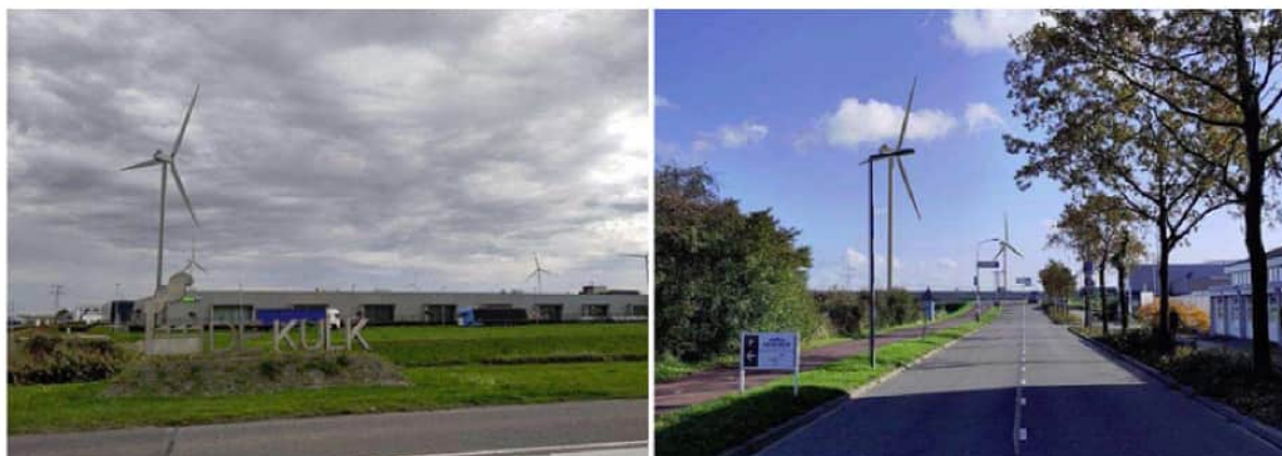
Figuur 5.24 Visualisatie vanaf standpunt 3 (links) en standpunt 7 (rechts) [bron: FMT]
