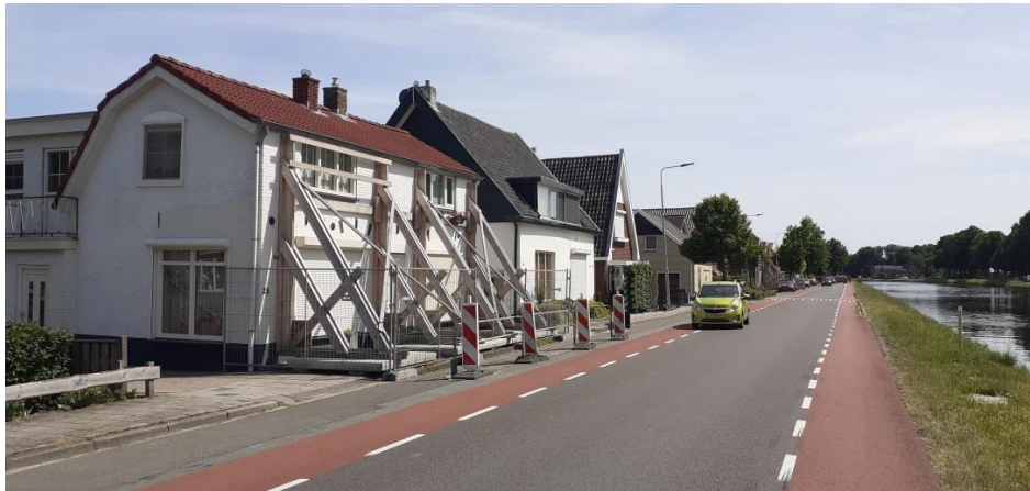
Figuur 1 Twee verzakte huizen langs het kanaal bij de Vriezenveenseweg
