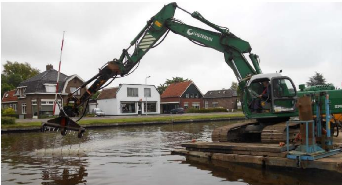
Figuur 6 Het aanbrengen van bentonietmatten in Daarlerveen
