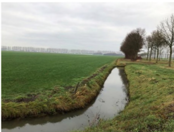
FIGUUR 4: WATERAFVOERSLOOT TUSSEN DE PERCELEN
