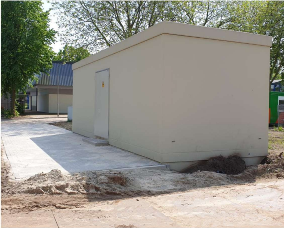
Afbeelding: schakelstation in Borger
